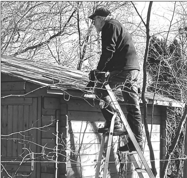
Dakherstel van de schuur
